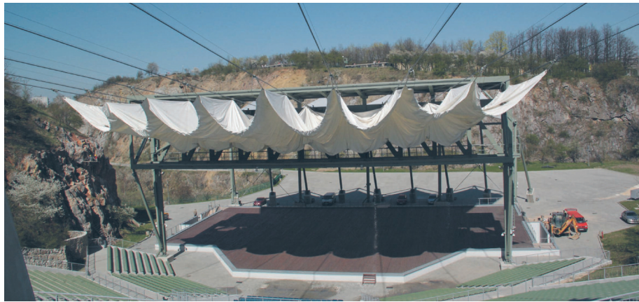
Dach membranowy nad Amfiteatrem Kadzielnia w Kielcach. Projekt był prezentowany na konferencji w Sofii. Pora firmą Cad-Mech tylko kilka firm na świecie wykonuje podobne instalacje
